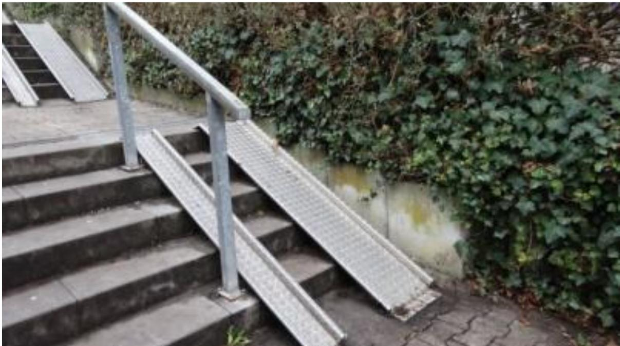
Dies kann man mit einfachen Mitteln verhindern. Man müsste z.B. lediglich entsprechend zugeschnittenen Holzklötze zwischen Treppe und Blech anbringen und dies gut und an jeder Treppenstufe festschrauben. Dazu ein Bild einer stark begangenen Treppenanlage in einem großen Touristenzentrum am Bodensee:
