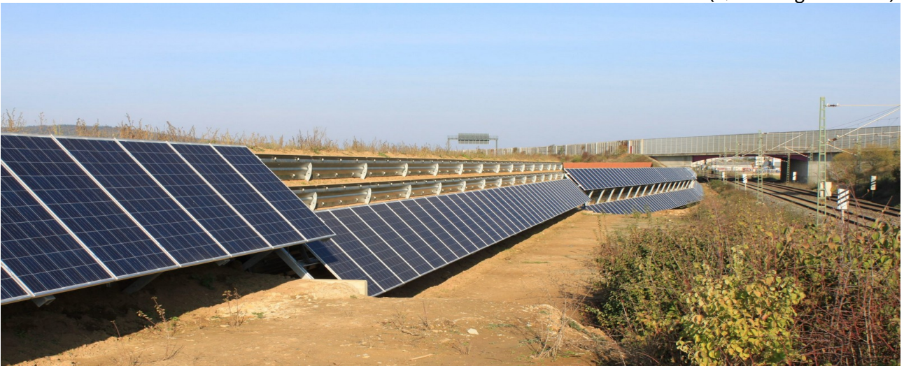
Lärmschutz und Photovoltaik an der Bahn bei Reudorf
