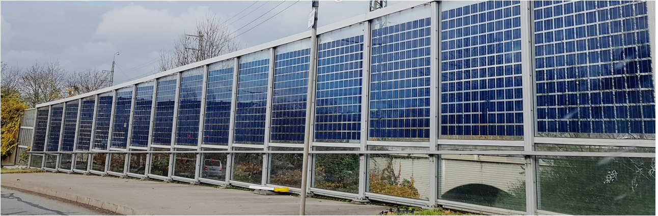
Lärmschutz und Photovoltaik an der Bahn in München
